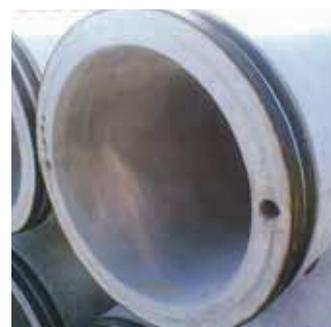
滑材の配送は、継手部の可とう性を保つ為、管体に埋め込んださや管の中にナイロンパイプを通す方式を採用しました。
